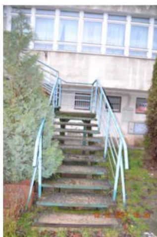
Fot.11 Schody stalowo-żelbetowe. Na piętro.
