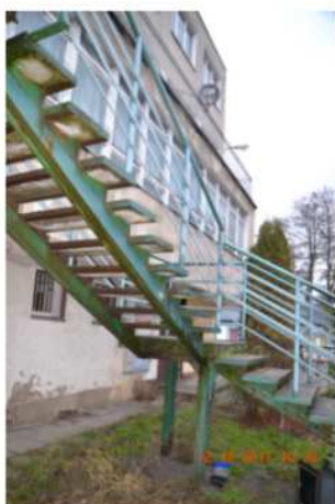
Fot.10 Schody stalowo- - żelbetowe na piętro. Stan techniczny - ZADOWALAJĄCY.
