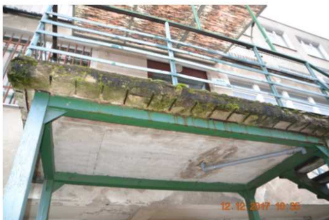
Fot.8 Schody na piętro, stalowo-żelbetowe.
