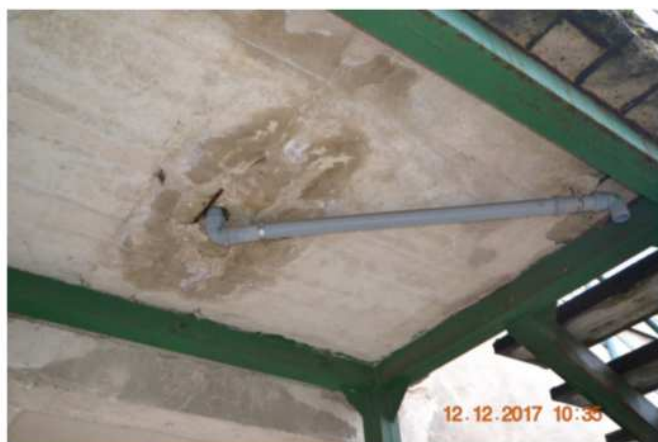
Fot.9 Schody z fot.8. Nieszczelność w płycie podestu.
